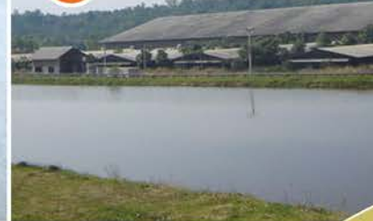
5 ระบบบำบัดน้ำเสีย/ปุ๋ยน้ำ
